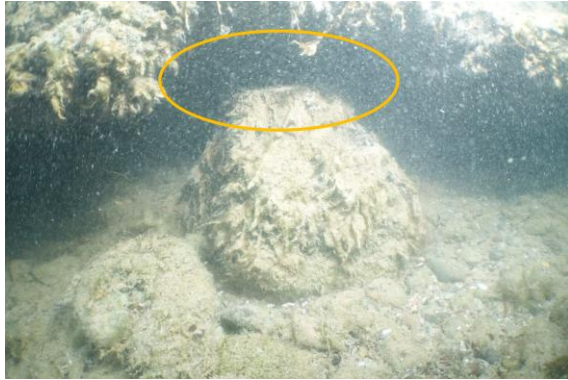
Abb. 12: Pfahlfundation nicht kraftschlüssig mit Mauer verbunden, starke Abrasion
