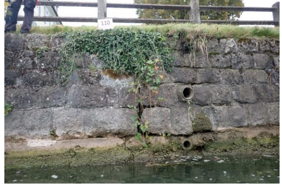
Abb. 13: Risse, offene Fugen und Bewuchs und Abrasion im Wasserspiegelbereich
