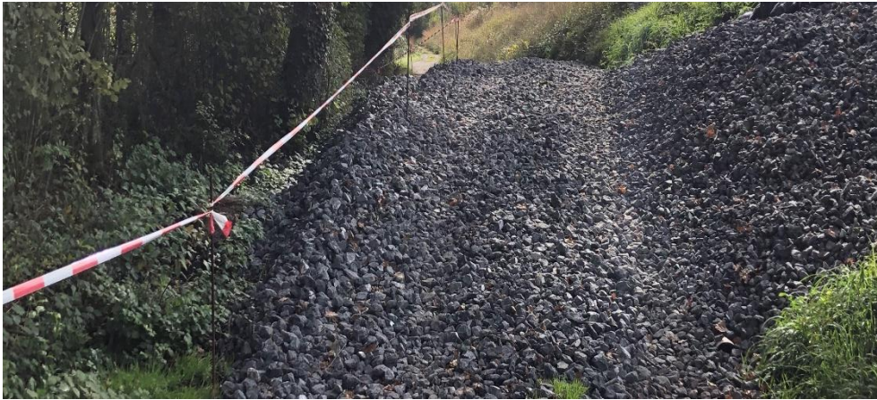
Abb. 3: Dammverstärkung beim Hochwasser 2021
