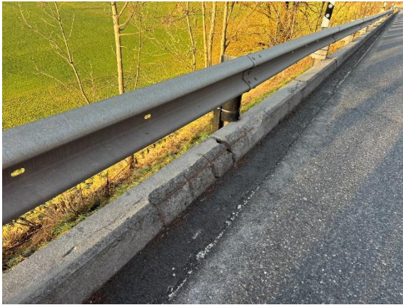
Abb. 9: Freistehende Bewehrung bei Stützmauer Chuenzrank
