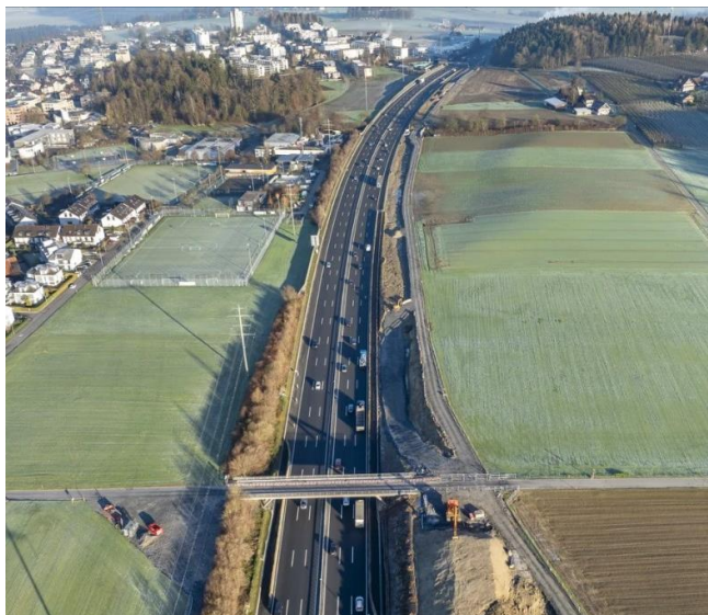
Abbildung 5: Bau der Umfahrung Cham–Hünenberg UCH auf der Ostseite der Autobahn; im Vordergrund die Brücke Ober-Ehret
