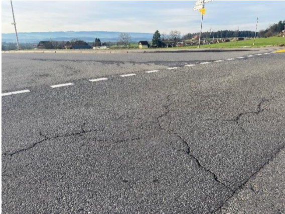
Abb. 9: Längs- und Querrisse (Netzrisse)
