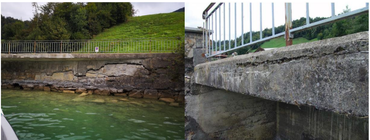
Abb. 4: Risse, Betonabplatzungen, korrodiertes Geländer Ufermauer Denkmal 2
