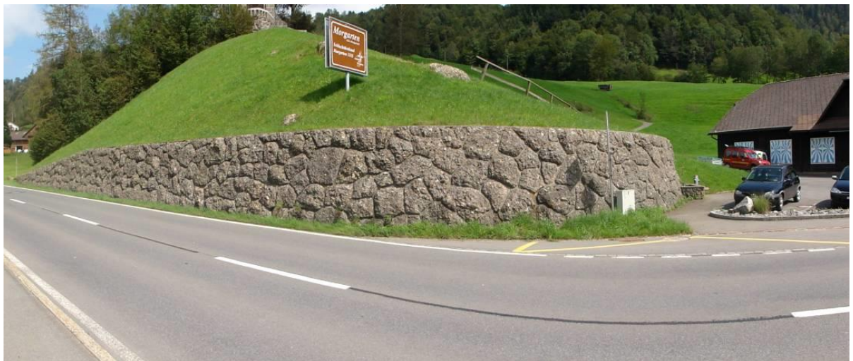
Abb. 7: Stützmauer Denkmal (Zyklopenmauerwerk in Nagelfluh)
