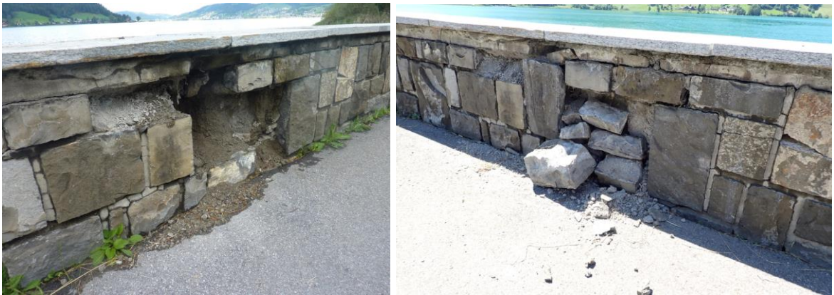
Abb. 3: Steinausbrüche Ufermauer Denkmal 1 (wurden in der Zwischenzeit geflickt)
