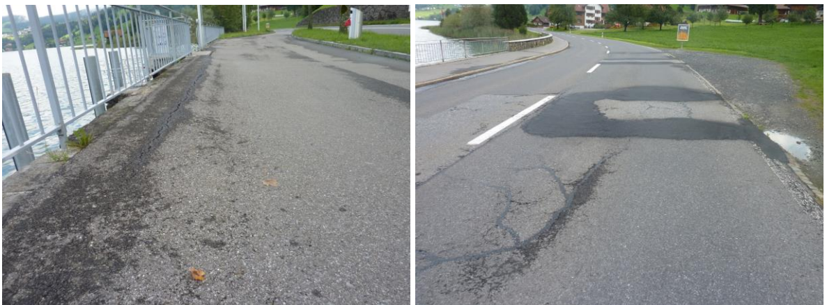
Abb. 5: Absenkung Trottoir sowie Netzzrisse und Flicker von Belagsschäden
