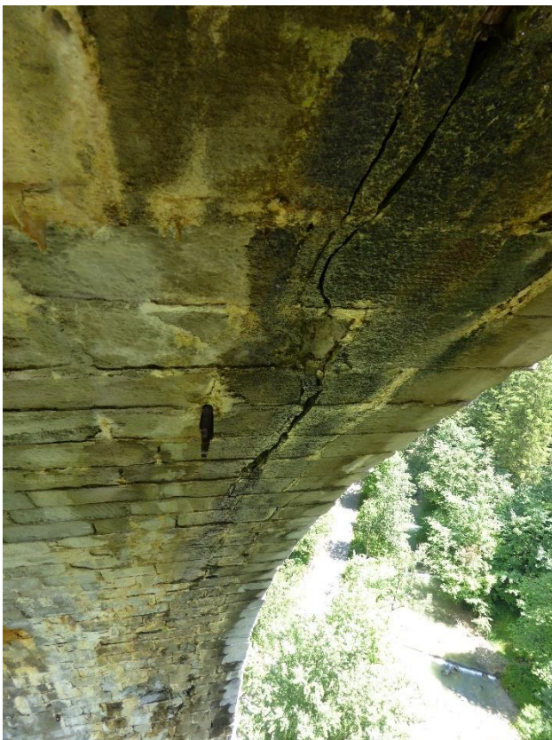
Abb. 3 u. 4: Risse in den Bogenuntersichten
