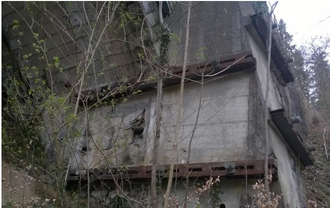
Abb. 5: prov. Sicherung Widerlager Seite Ägeri
