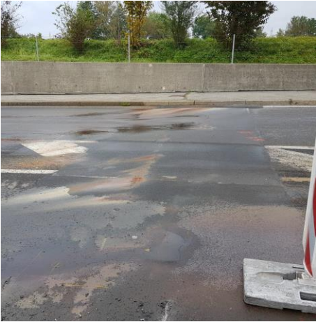
Abb. 2: Wassereintritt Blockfuge
