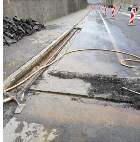
Abb. 3: regelmässige Flickarbeiten
