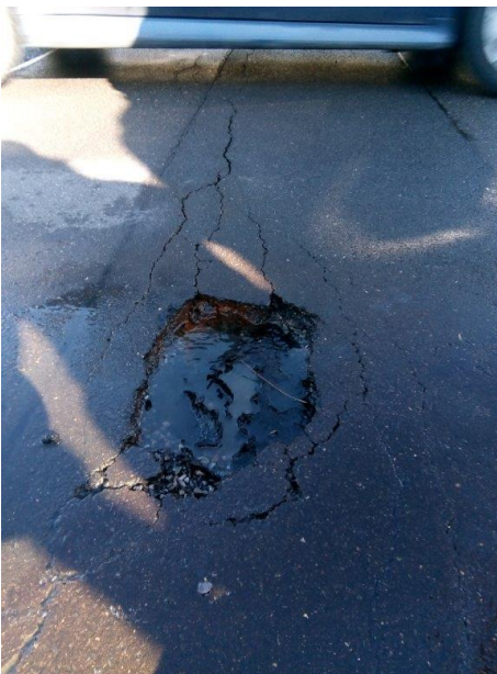
Abb. 4: Belagsschaden infolge Frosteinwirkung
