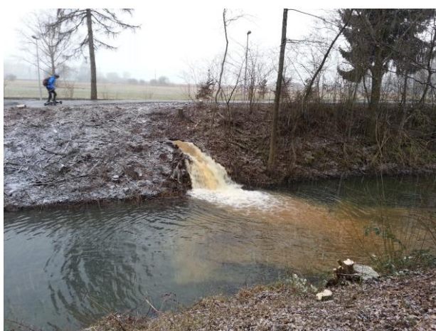
Abb. 5: Auslauf Pumpwerk Grundwasserwanne in den Dorfbach
