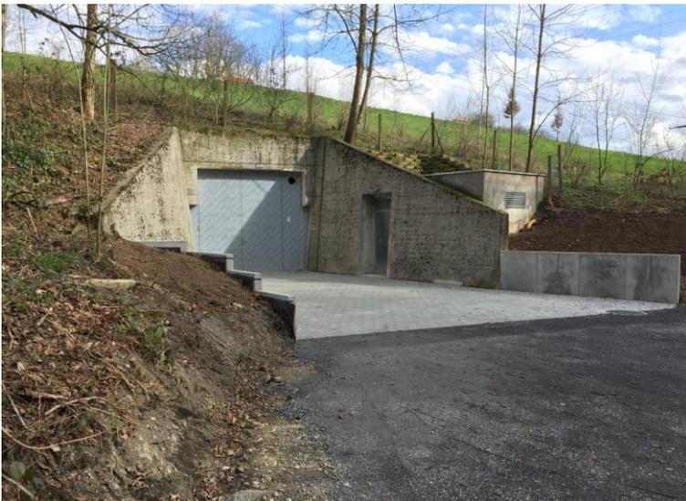
Abbildung 19: Beispiel eines Stollenportals (Zugang zu einem unterirdisch verlaufenden Stollen)
