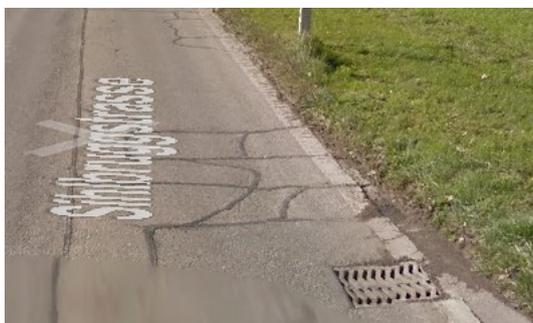
Abb. 6: Mangelhaftes Entwässerungssystem
