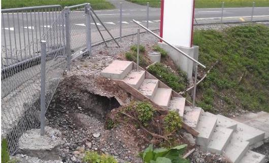
Abb. 7: Schaden nach Starkregenereignis
