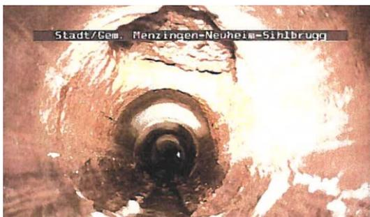
Abb. 10: Schadhafte Strassenabwasserleitung
