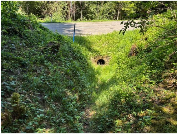
Abb. 12: Sanierungsbedürftiger Bachdurchlass Abb. 13: Renaturierter Bättlerbach
