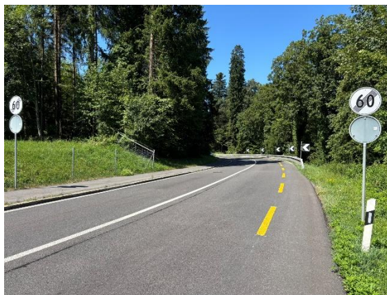
Abb. 5: Kurve nach Walterswil Blickrichtung Baar (mangelnde Sichtweite)
