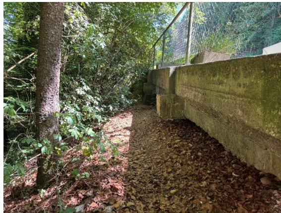
Abb. 11: Stützmauer «Parkplatz Hegiwald»
