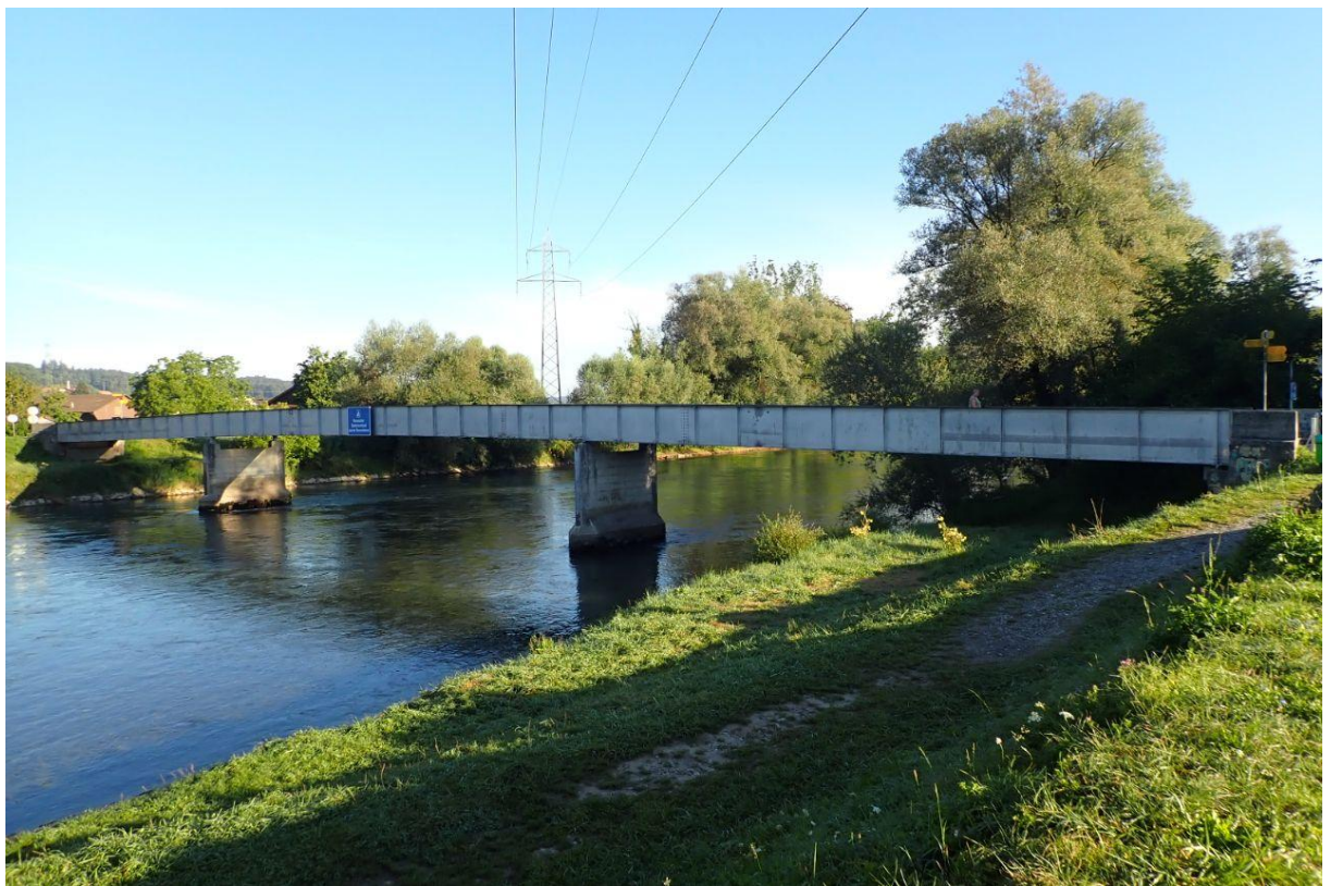
Abb. 1: oberwasserseitige Ansicht der bestehenden Reussbrücke
