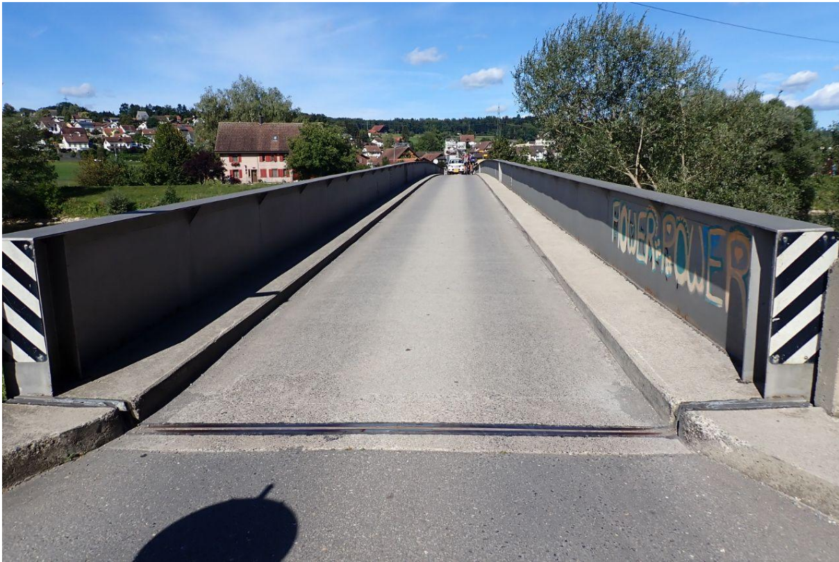
Abb. 2: Ansicht Fahrbahn von Seite Zug aus gesehen
