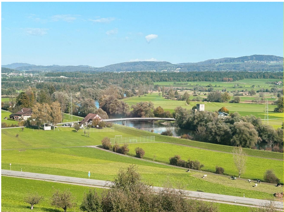
Abb. 3: Blick auf die neue Reussbrücke von Mühlau aus gesehen
