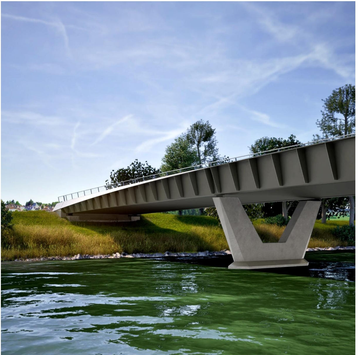
Abb. 4: Untersicht neue Brücke mit Stütze Seite Mühlau
