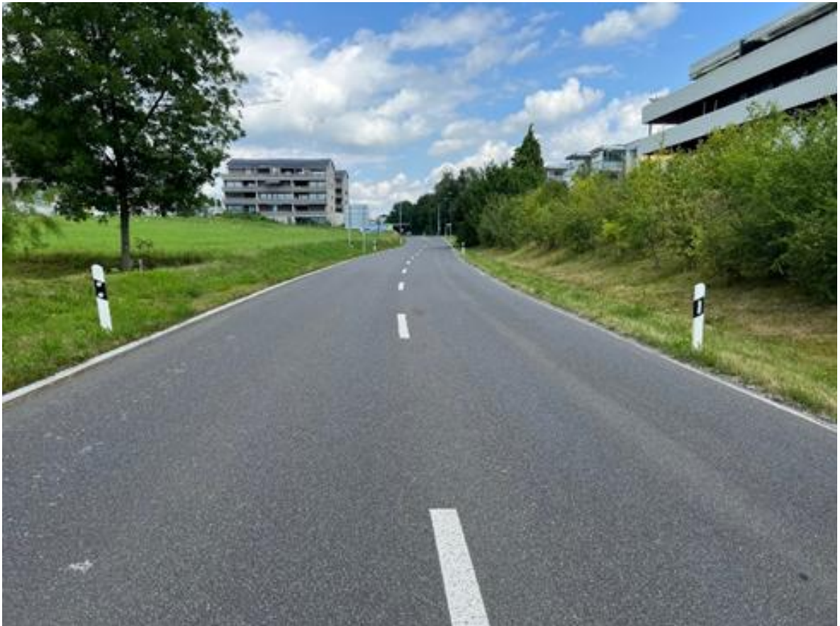
Titelbild: Knauerstrasse in Steinhausen mit lärmarmen Deckbelag
