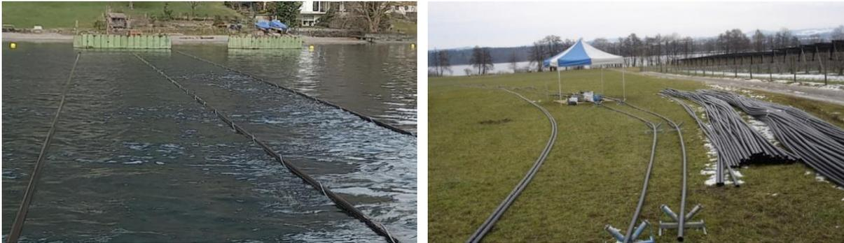
Abbildung 8: Linke Figur: HDPE-Leitung mit Drahtseil umwickelt im schwimmenden Rohrlager. Rechte Figur: Rohrschweisplatz auf einer Wiese am Seeufer (Quelle: Willy Stäubli Ing. AG 2023)
