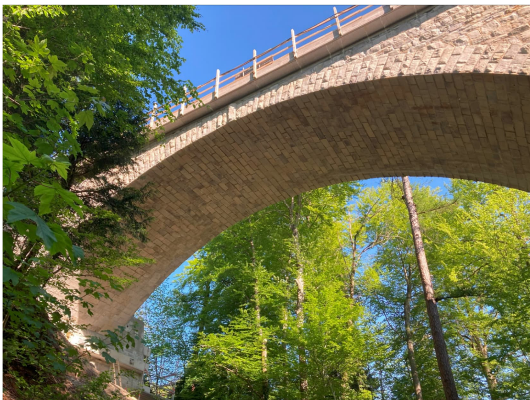
Foto: Brückenbogen Seite Menzingen mit bereits abgeschlossener Instandsetzung
