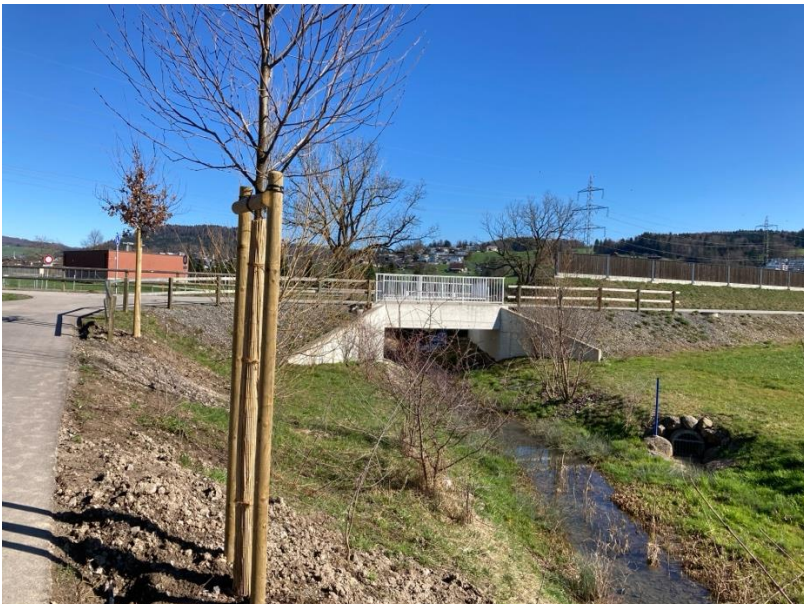
Bestehender Durchlass Grossacherbach Tangente Zug/Baar
