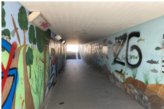
Abb. 2: SBB-Unterführung Blickrichtung Süd
