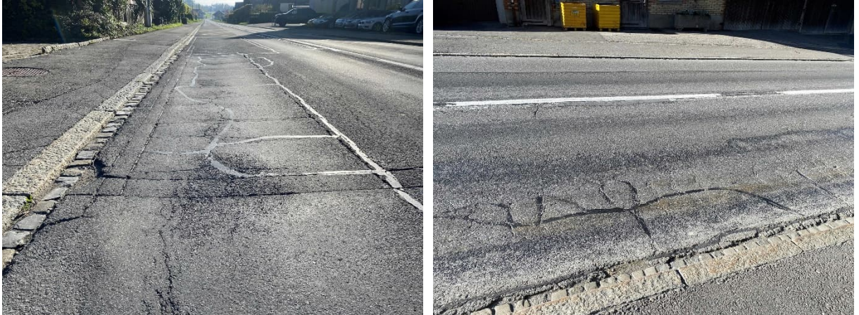
Abb. 7 + 8: Schadhafter Strassenbelag
