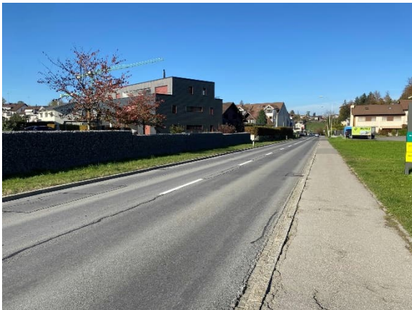
Abb. 3: Fehlendes Trottoir Blattmatt
