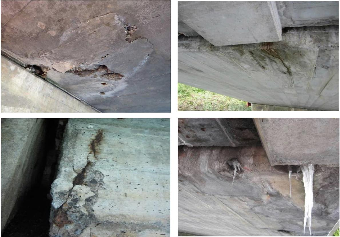
Abbildung 1 bis 4: Bewehrungskorrosion, Betonabplatzungen und Aussinterungen an der Brückenunterseite
