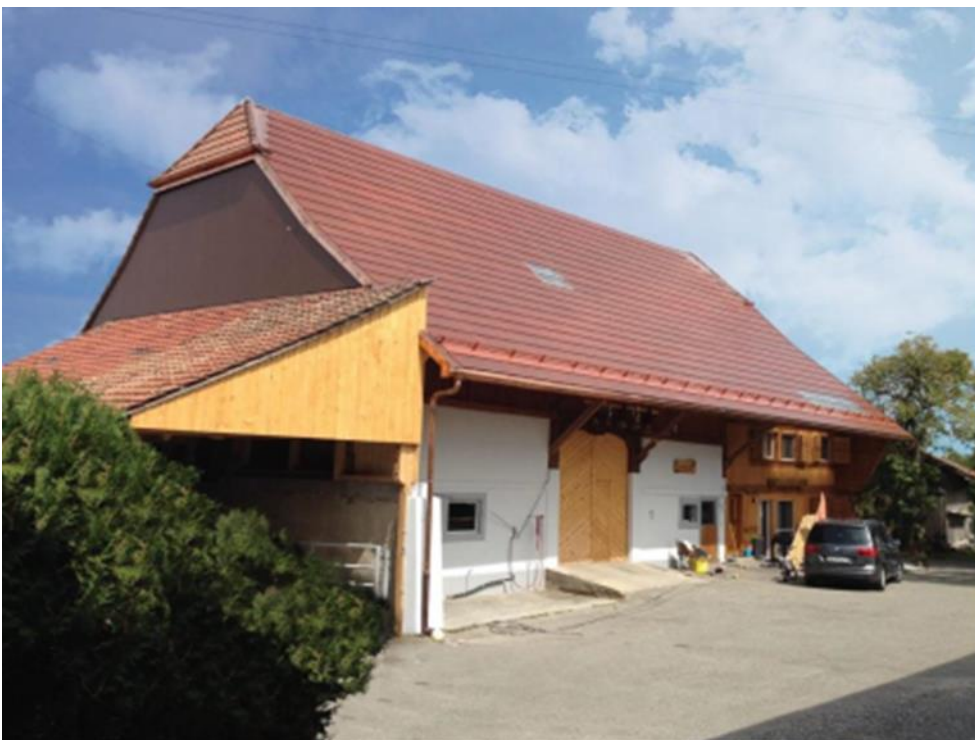
Das Pilotprojekt in Ecuwillens mit Unterstützung des Amtes für Energie und des Amtes für Kulturgüter des Kantons Freiburg sowie des Bundesamts für Energie im Jahr 2017
