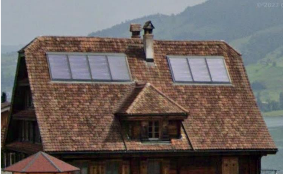
Beispiel aus Luzern einer PV-Anlage (keine Voldachanlage) auf Baudenkmalern, welches den Vorgaben des Zuger Denkmalschutzes entsprechen würde
